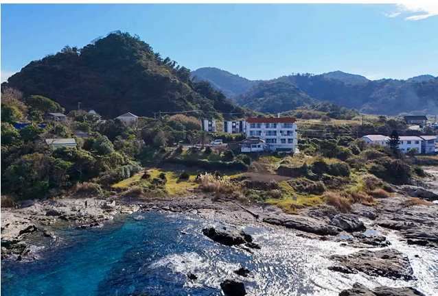
敷地周辺を海から
