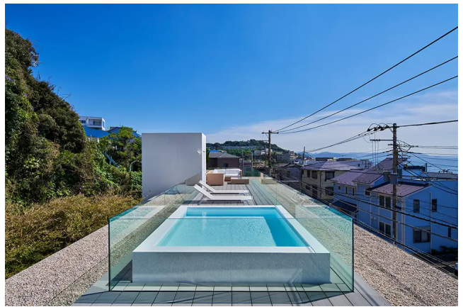
屋上のスカイプール
