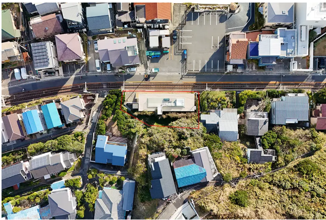
真上から（赤枠内：敷地）
