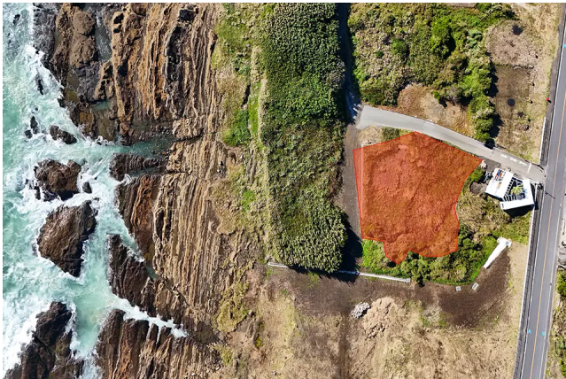
真上から（オレンジ部分：敷地）
